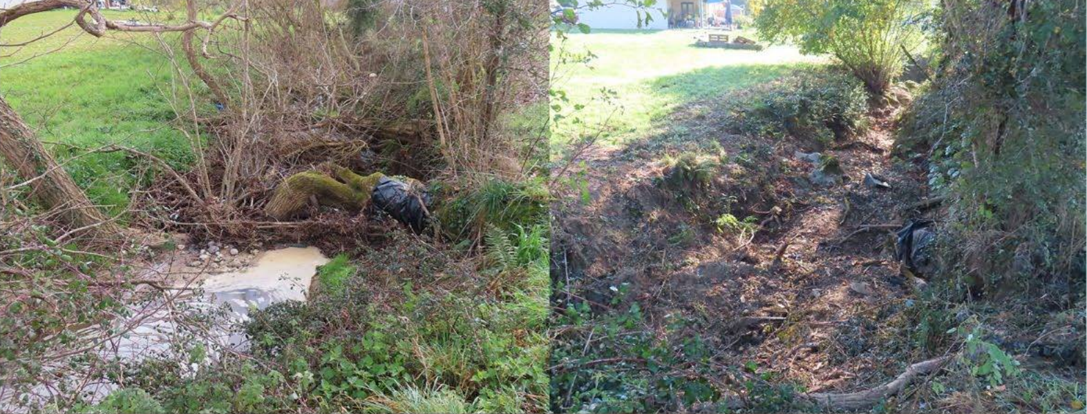
Restauration Lous Baigts_Baigts-de-Béarn avant travaux
