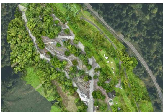
Écoulement au droit du camping d'Urdos le 09/09/2024
