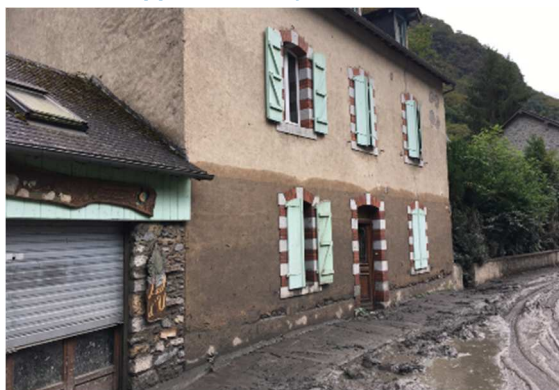
Laisse de crue à Etsaut le 9/09/2024
