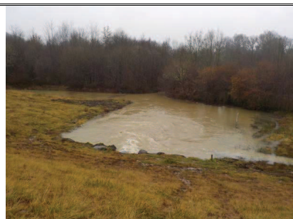
Barrage écreteur – Bassin de dissipation
