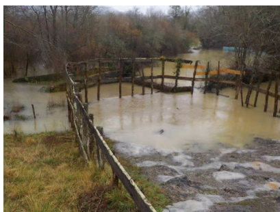
Barrage écreteur – Piège à embâcles
