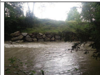
Le Vert d'Arette à Aramits, enrochement au stade
