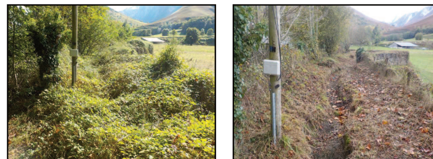
Avant et après intervention
