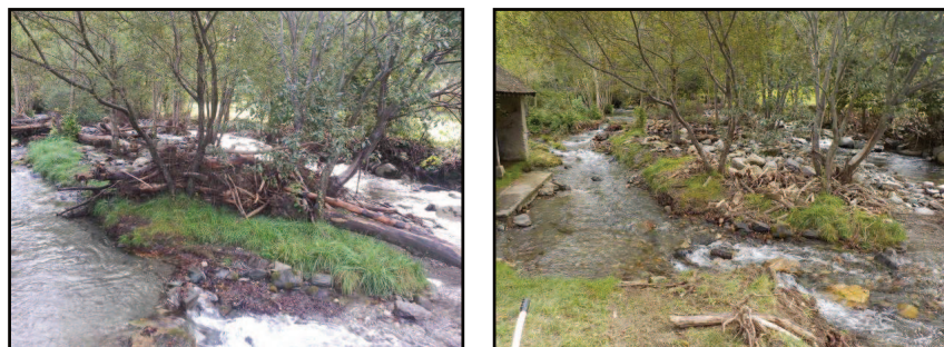
Avant et après intervention
