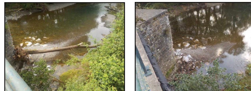
Avant et après intervention
