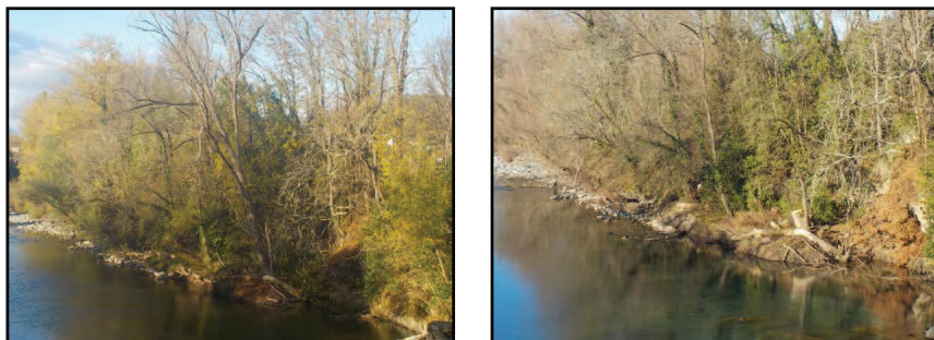
Avant et après intervention
