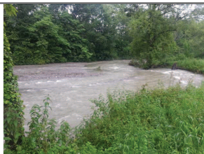
Le Vert d'Arette à Arette, érosion de berge en amont du pont Escamet
