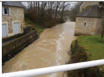
Aval du pont de la départementale au village
