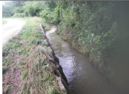
Le Laüs à Ogenne Camptort, protection de berge en mont de la Départementale
