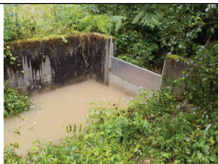
Ouvrage de décharge du Lapeyre après réparation
