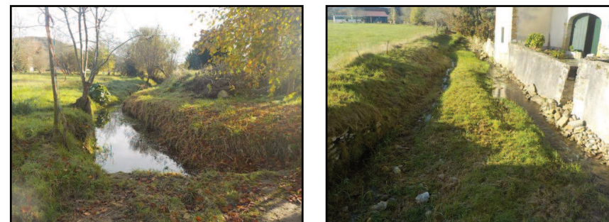
Avant et après intervention
