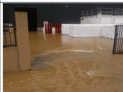
Inondation de l'usine
