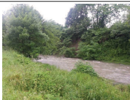
Le Vert d'Arette à Arette, effondrement de falaise en RD, aval du pont Escamet
