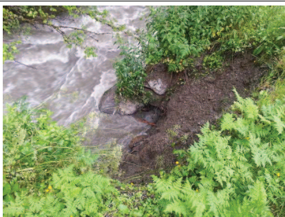
Le Sadun à Etsaut, érosion de berge au droit du local communal
