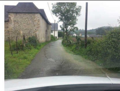
L'Escou à Escou, débordement sur la voirie menant à la place du village
