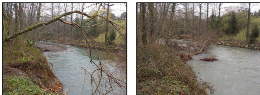
Avant et après intervention
