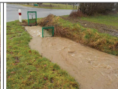
Le Jouers au piège à embâcle de l'ancienne Nationale
