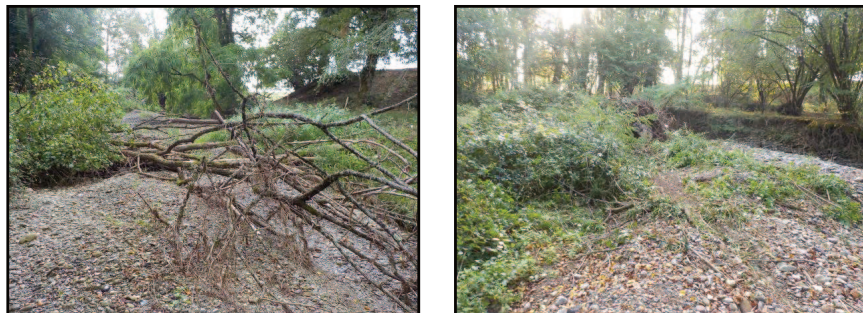
Avant et après intervention
