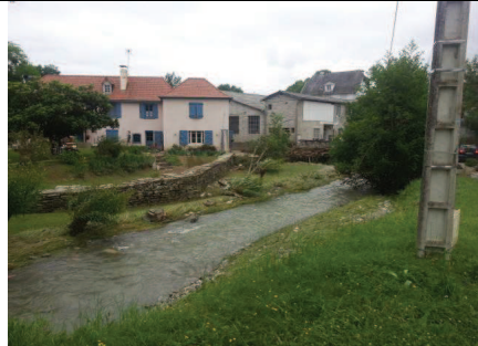
Le Laüs à Navarrenx, maisons fortement inondées lors de la crue
