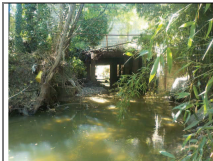
Le Laüs à Navarrenx, pont de l'Usine
