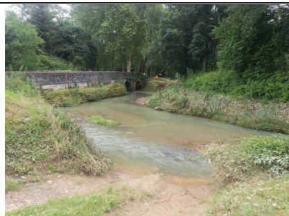
Le Layous à Lay-Lamidou, débordement sur voirie et maisons
