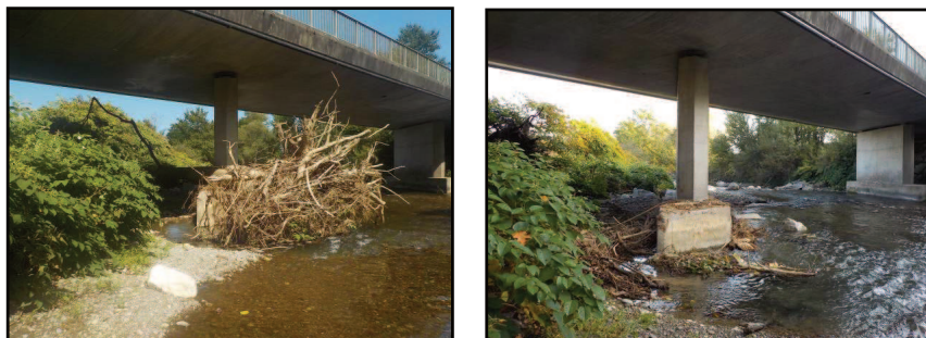
Avant et après intervention
