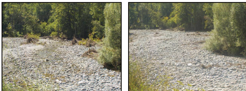
Avant et après intervention
