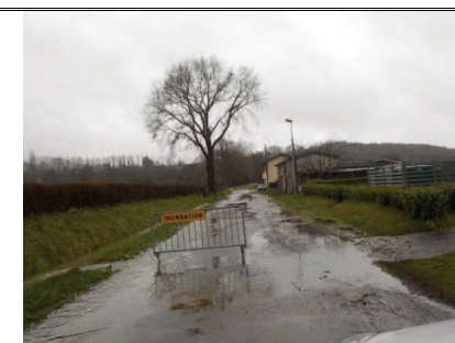
Route fermée sur 10 m à proximité du camping
