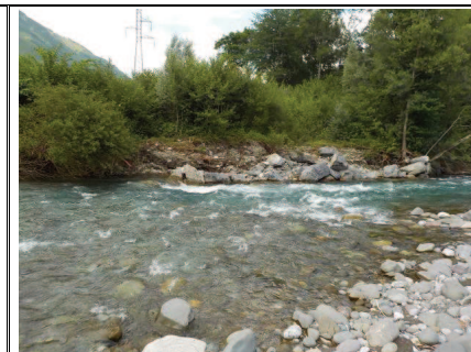
Le Gave d'Aspe à Lées Athas, dégradation importante de la protection de berge en amont de la station d'épuration
