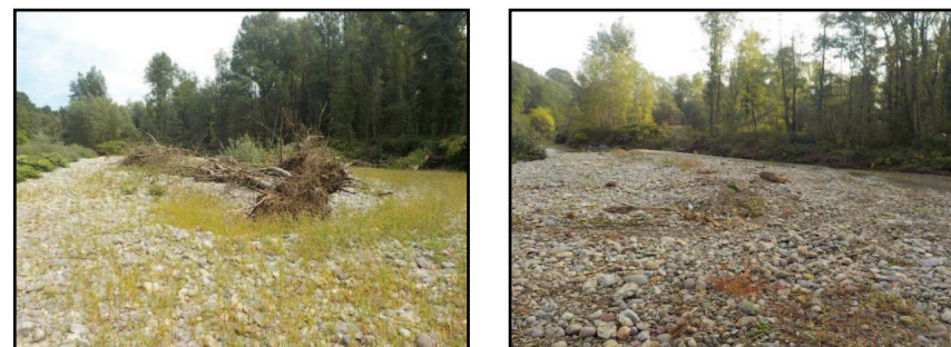
Avant et après intervention
