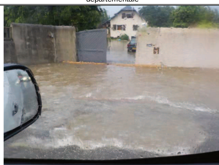
Inondation des maisons autour de la départementale
