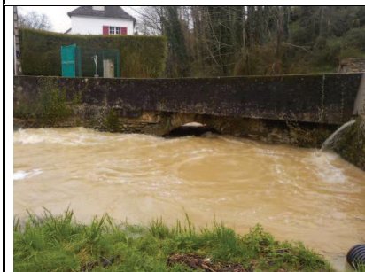
Le Layous en amont du pont au chemin du Moulin
