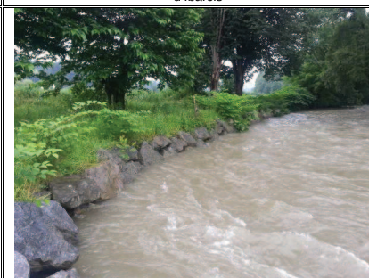
Le Vert d'Arette à Aramits, enrochement en amont de la confluence avec l'Ibarcis
