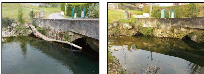
Avant et après intervention
