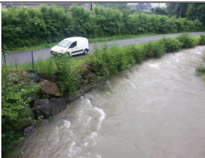
Le Vert d'Arette à Arette, Protection de berge en amont de la passerelle
