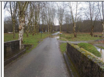
Inondation de la route sur une dizaine de mètres
