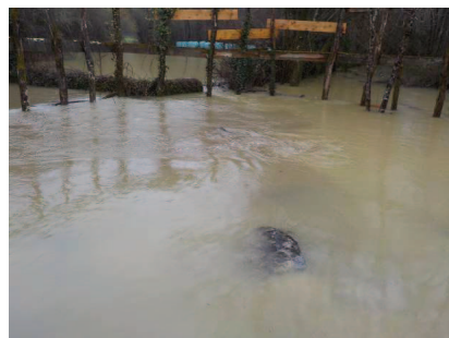
Barrage écreteur – Siphon créé par la buse
