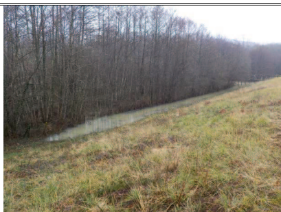
Barrage écreteur – Mise en charge amont
