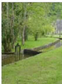
Ouvrages de petite hydraulique aux abords soignés, sur un petit affluent du gave.
