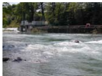
Dérivation du cours du gave d'Aspe pour la microcentrale électrique de Gurmençon
