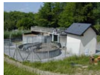
Station d'épuration en bord du gave d'Aspe à Eysus
