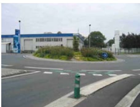
Entrée principale par la rue du Pic d'Arlet Fédéral Mogul
