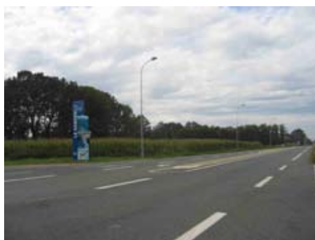
Entrée de la zone sur la RN 134
