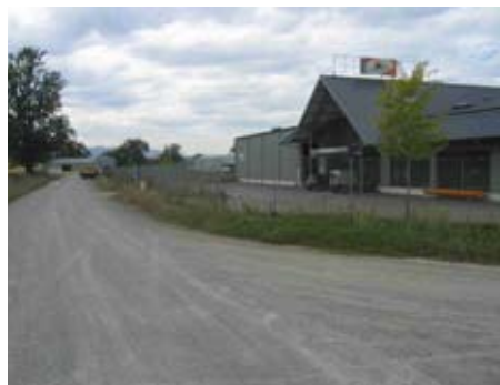
Nouveau secteur en cours d'aménagement: Euralis
